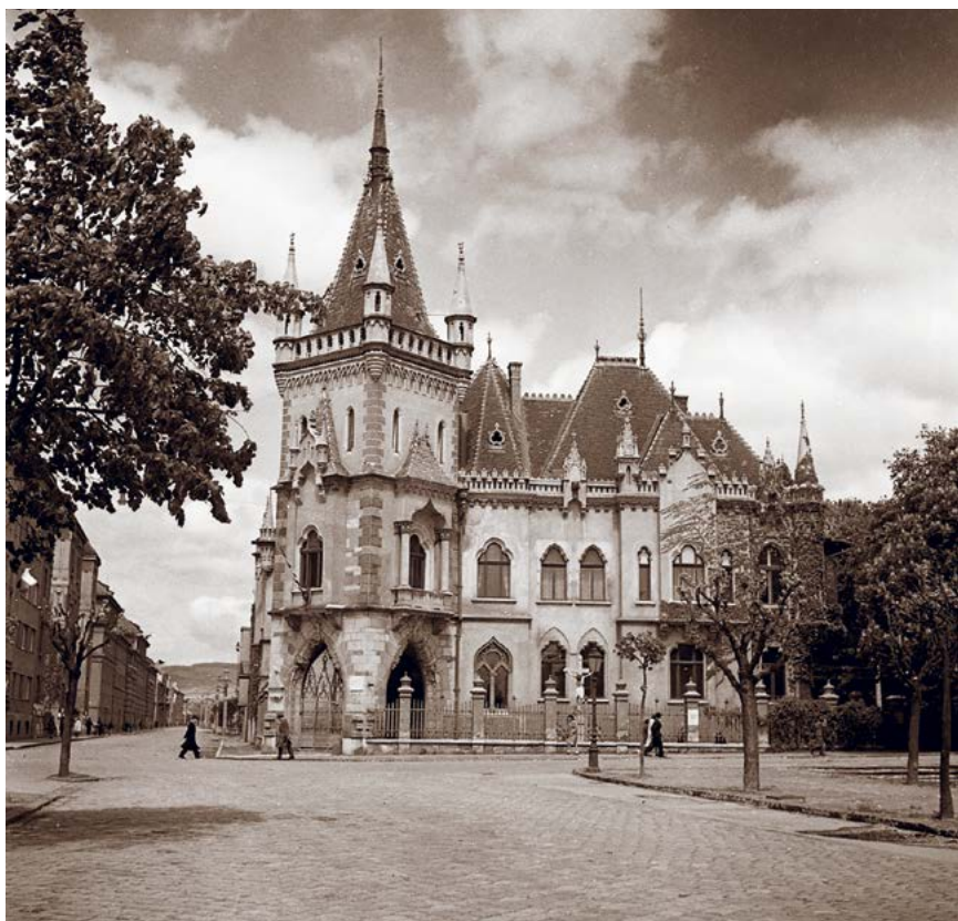
Obr. 4 Pohľad na Jakabov palác, v ktorom býval prezident E. Beneš v Košiciach.
